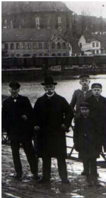
Bürgermeister Emil Plewka auf der Pontonbrücke im März 1925 bei der Übergabe der städtischen Pontonbrücke an die staatliche Bauverwaltung.
