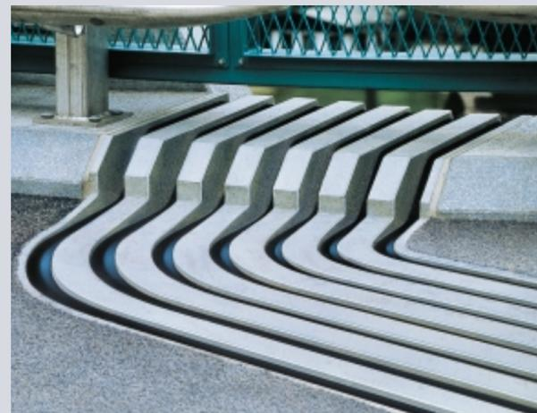
Anschluß zwischen mehrprofiliger Querfuge und einprofiliger Längsfuge
