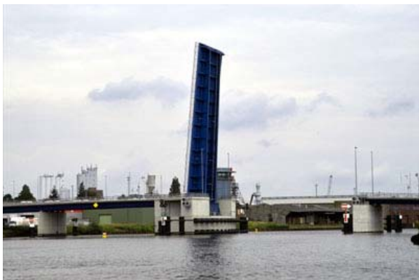
Stau am Ende der Überfahrt: Die neue vierspurige Eric-Warburg-Brücke endet bis Mitte 2008 in einer Baustelle. Foto: JW
