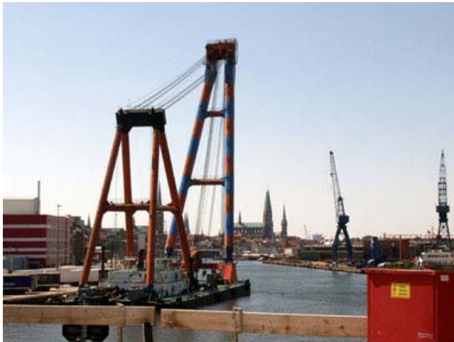
Der Schwimmkran Samson wird am Mittwoch das Brückenteil einhängen. Fotos: Holger Kröger
